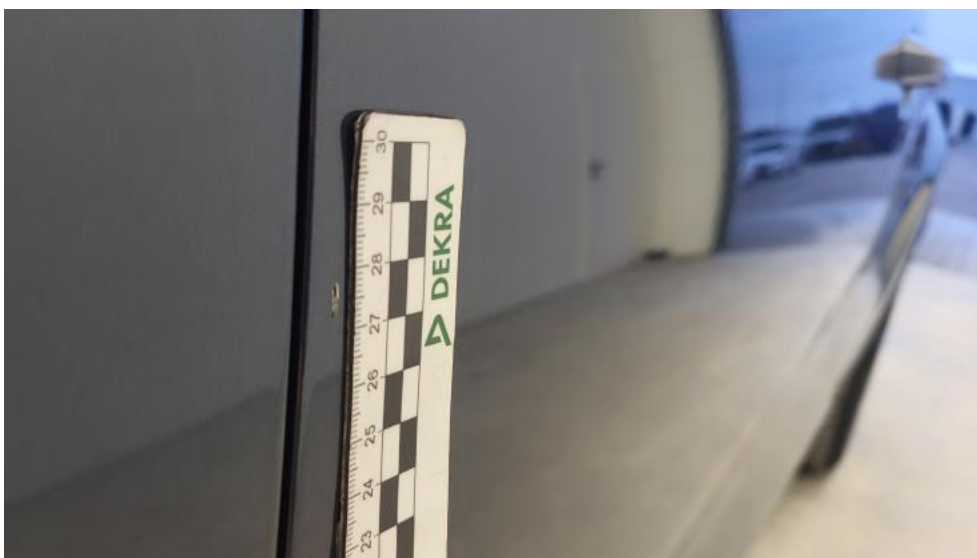
Fot. 66. Drzwi przed L - Inne 2
