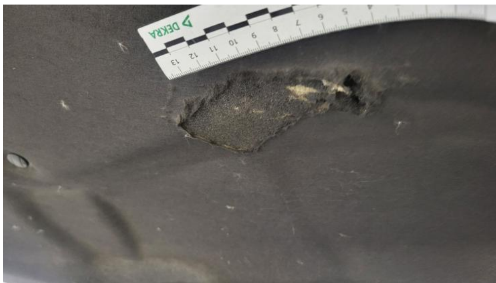
Fot. 39. Wykładzina pokrywy komory silnika - Pęknięcie/rozerwanie 1
