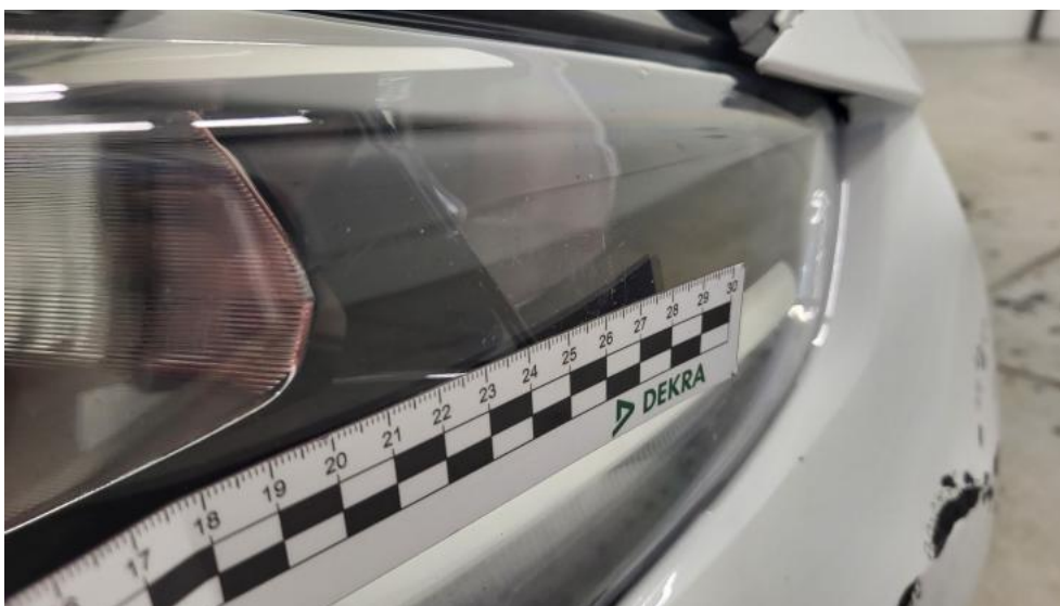
Photo 59. Reflektor P - Rysa/odprysk 1
