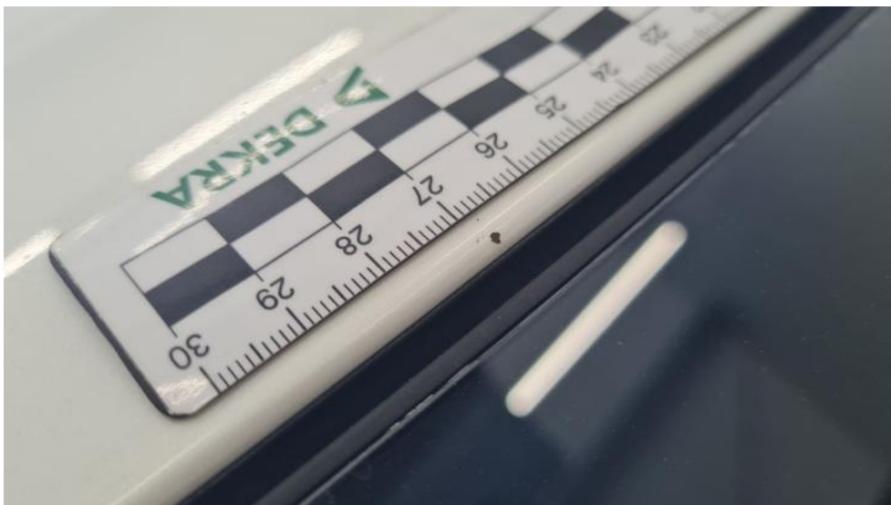
Fot. 49. Dach - Inne 1
