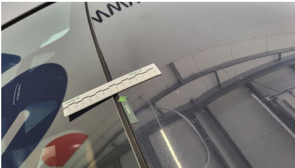
Fot. 51. Dach - zdjęcie poglądowe 1
