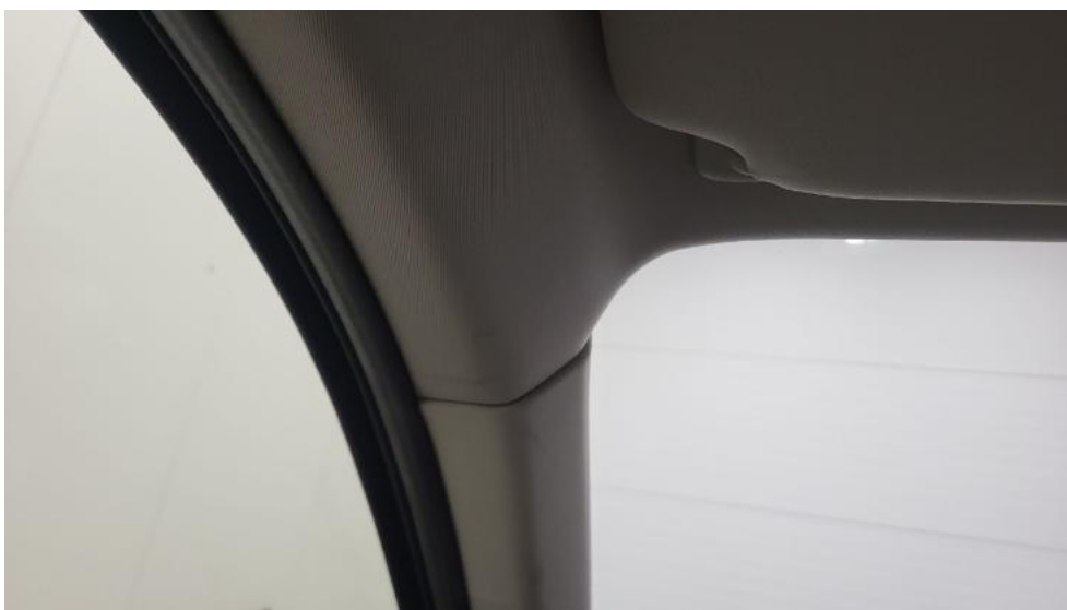
Fot. 61. Podsufitka - Inne 2
