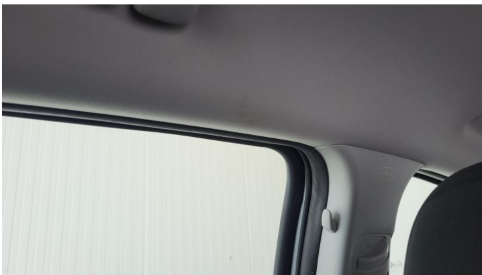
Fot. 71. Podsufitka - Inne 1
