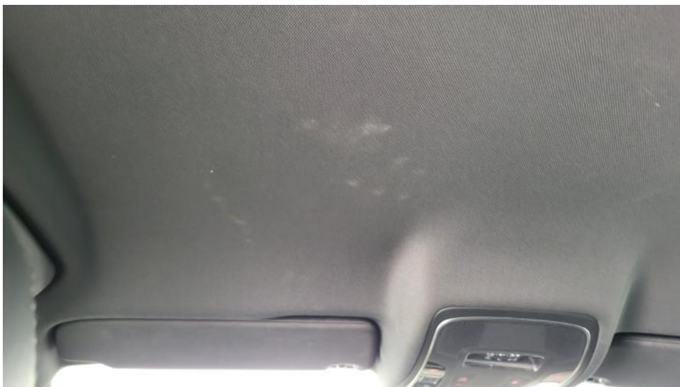
Fot. 81. Podsufitka - Inne 1
