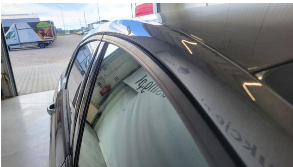
Photo 62. Słupek przedni P - Wgniecenie/odkształcenie 1
