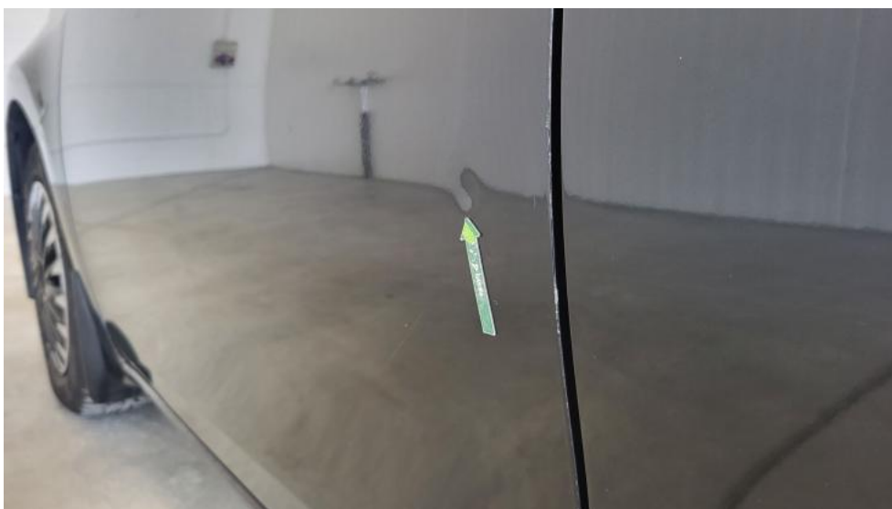
Fot. 98. Drzwi przed L - Wgniecenie/odkształcenie 1
