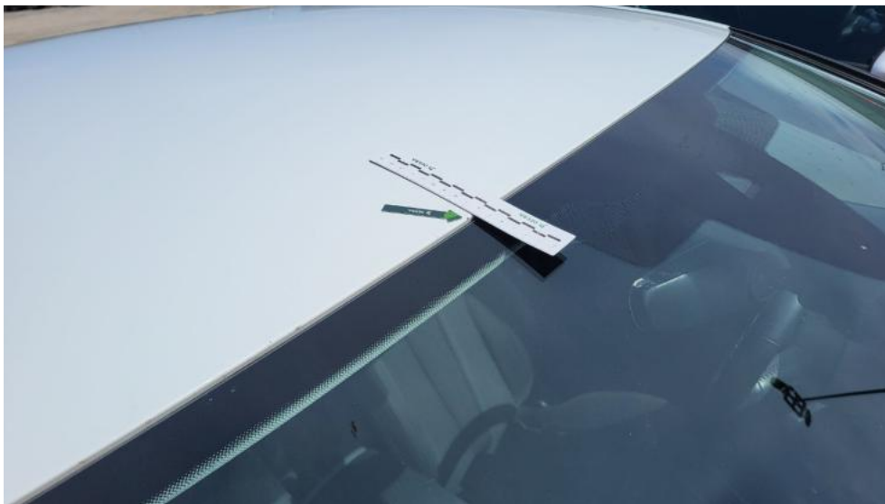
Photo 57. Dach - zdjęcie poglądowe 1
