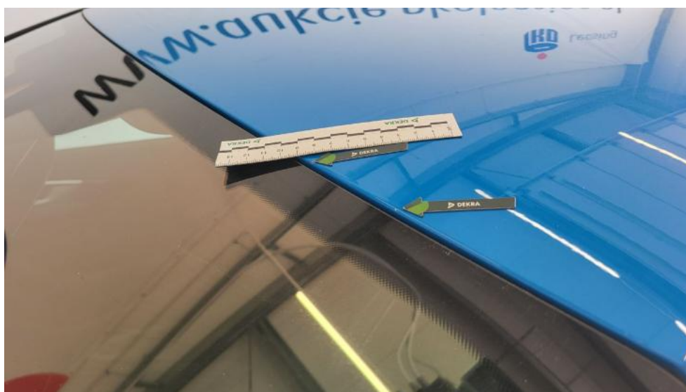
Fot. 70. Dach - zdjęcie poglądowe 1
