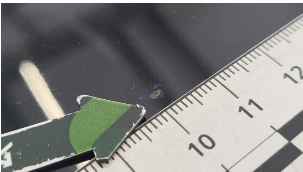
Fot. 96. Dach - Inne 2
