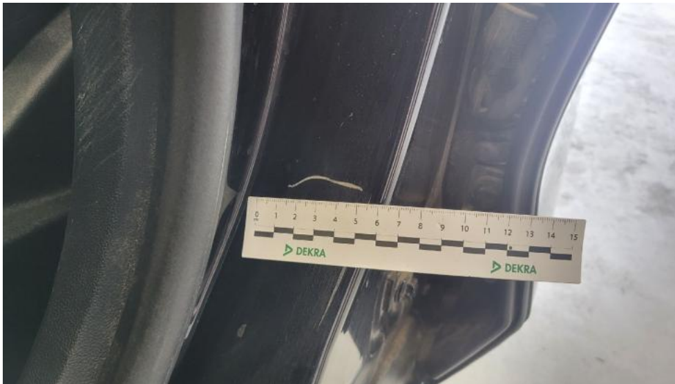
Fot. 91. Słupek środkowy L - Rysa/odprysk 1
