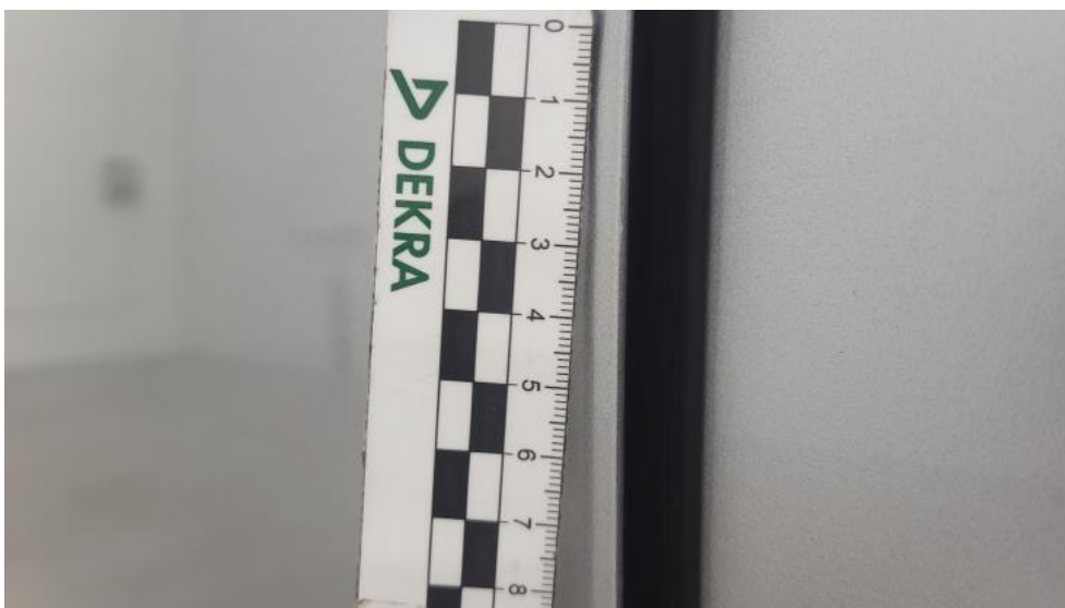
Photo 44. Drzwi przed L - Rysa/odprysk 1
