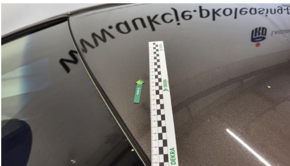
Fot. 60. Dach - zdjęcie pogładowe 1
