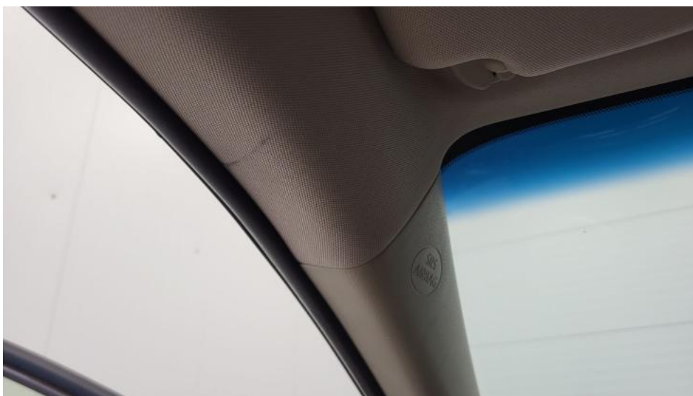
Fot. 77. Podsufitka - Inne 1
