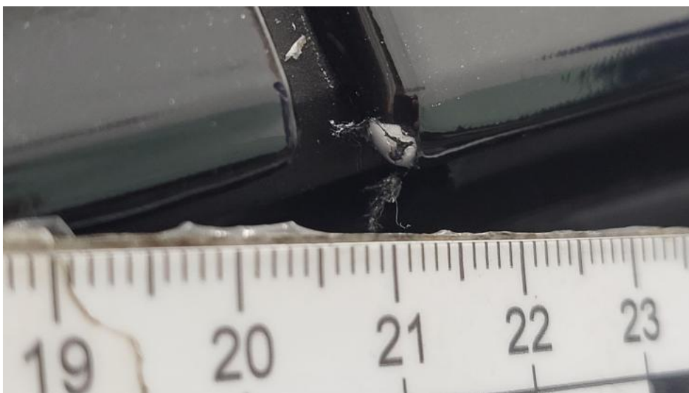
Photo 78. Dach - Rysa/odprysk 2
