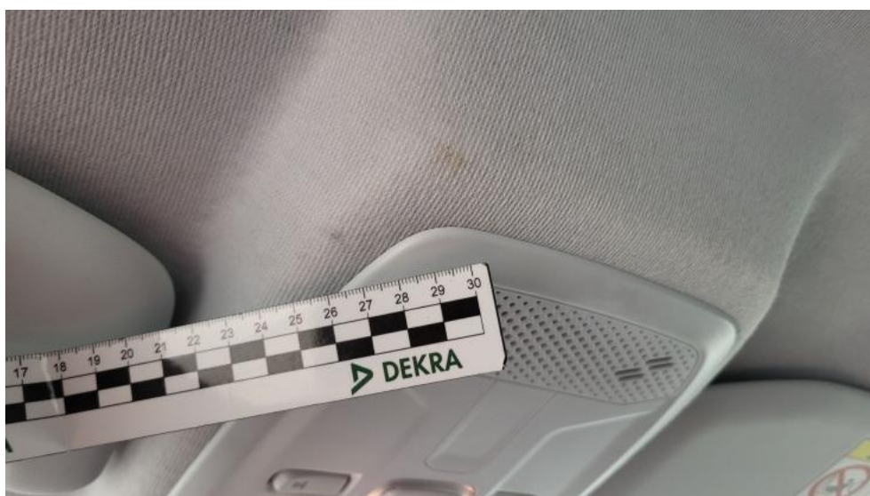
Fot. 80. Podsufitka - Inne 1
