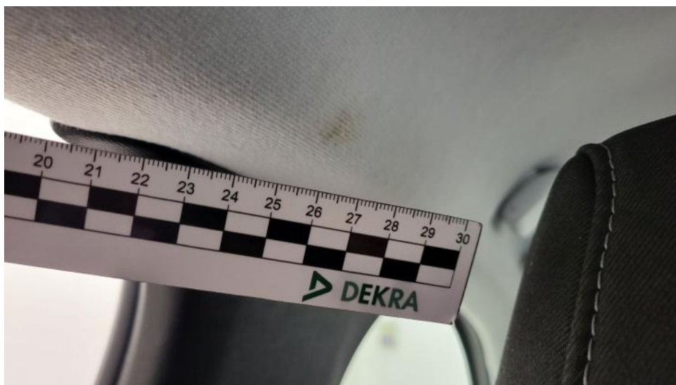
Fot. 82. Podsufitka() - Inne 3
