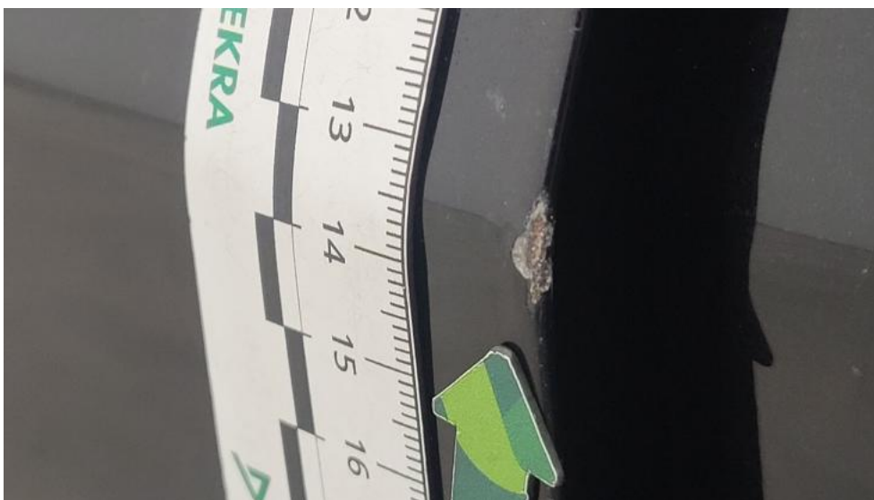
Fot. 71. Drzwi przed L - Inne 1
