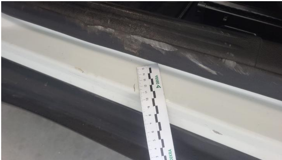
Fot. 57. Próg L - Rysa/odprysk 1
