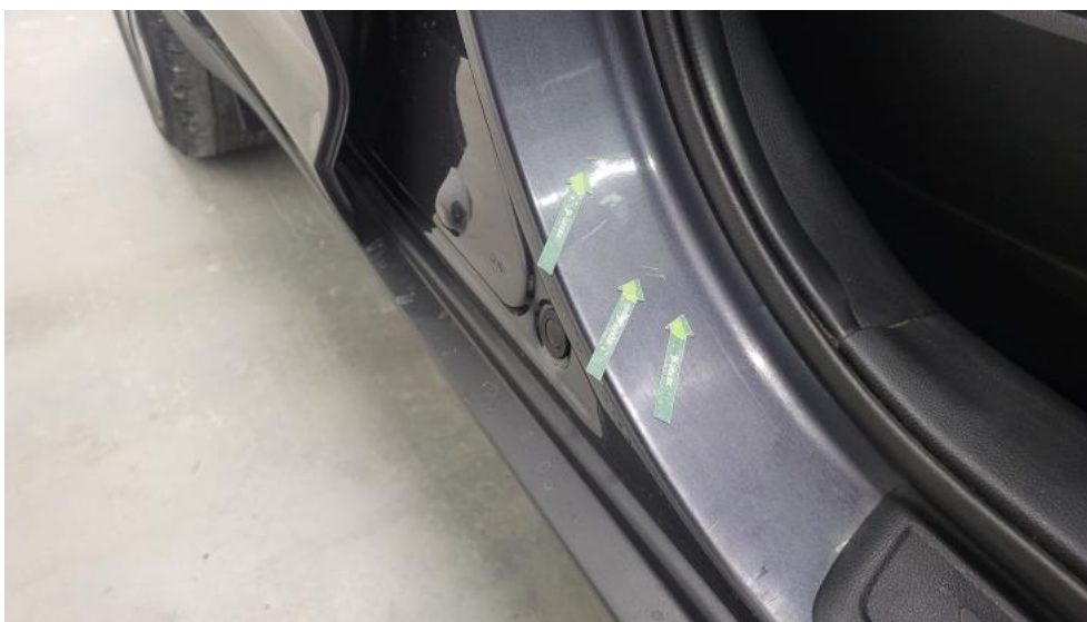
Fot. 73. Słupek środkowy P - Wgniecenie/odkształcenie 2
