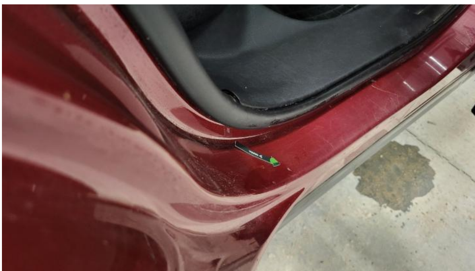
Photo 44. Próg P - Wgniecenie/odkształcenie 1
