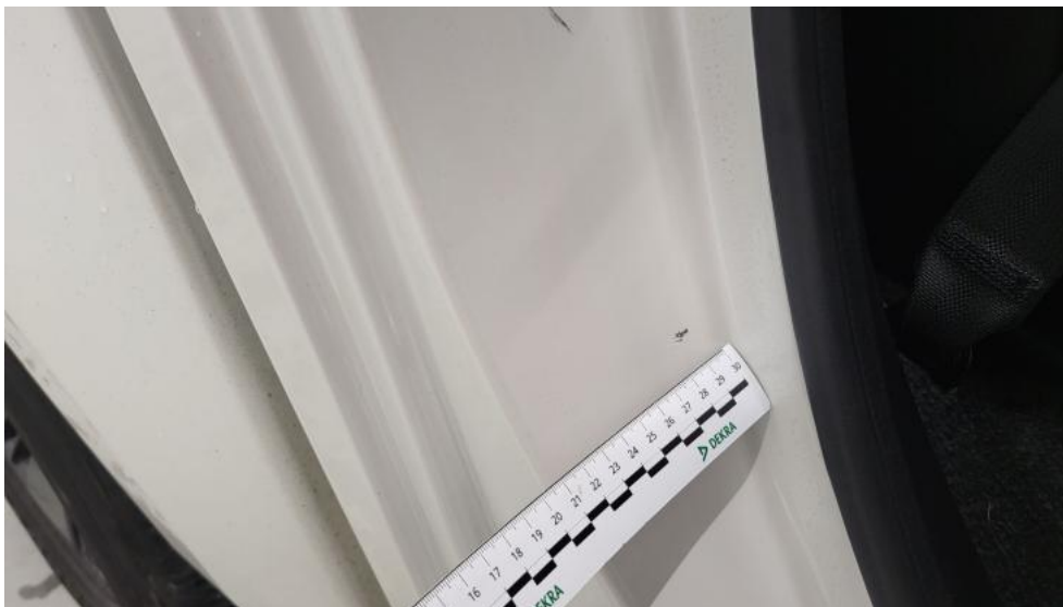
Photo 49. Stupek tylny prawy - Rysa/odprysk 1
