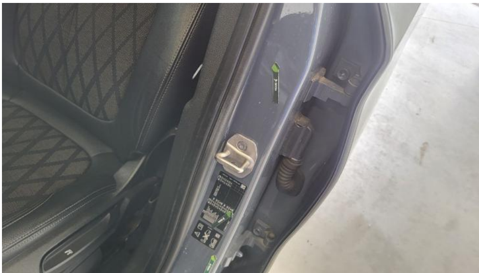
Fot. 81. Słupek środkowy L - Wgniecenie/odkształcenie 1
