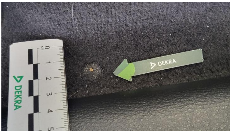
Fot. 93. Wykładzina podłogi - Inne 2
