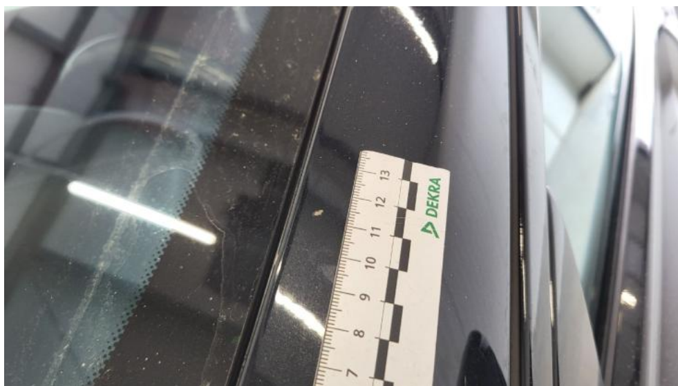
Fot. 65. Stupek przedni L - Rysa/odprysk 1
