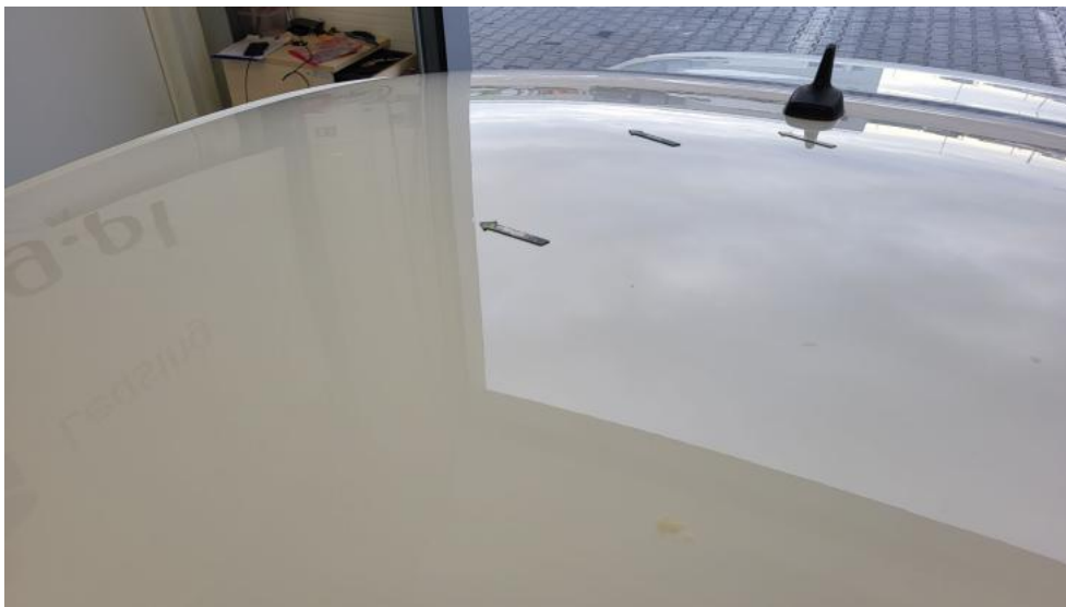
Fot. 89. Dach() - Wgniecenie/odkształcenie 3
