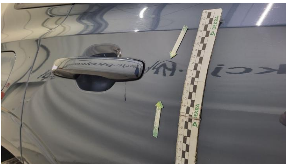
Fot. 57. Drzwi tylne P - zdjęcie pogładowe 1
