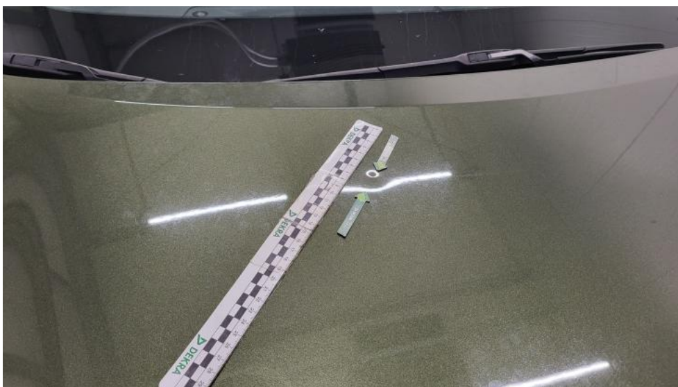
Photo 54. Pokrywy przód - Wgniecenie/odkształcenie 2
