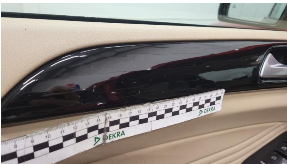
Photo 90. Tapicerka drzwi przednich L - Pęknięcie/rozerwanie 1
