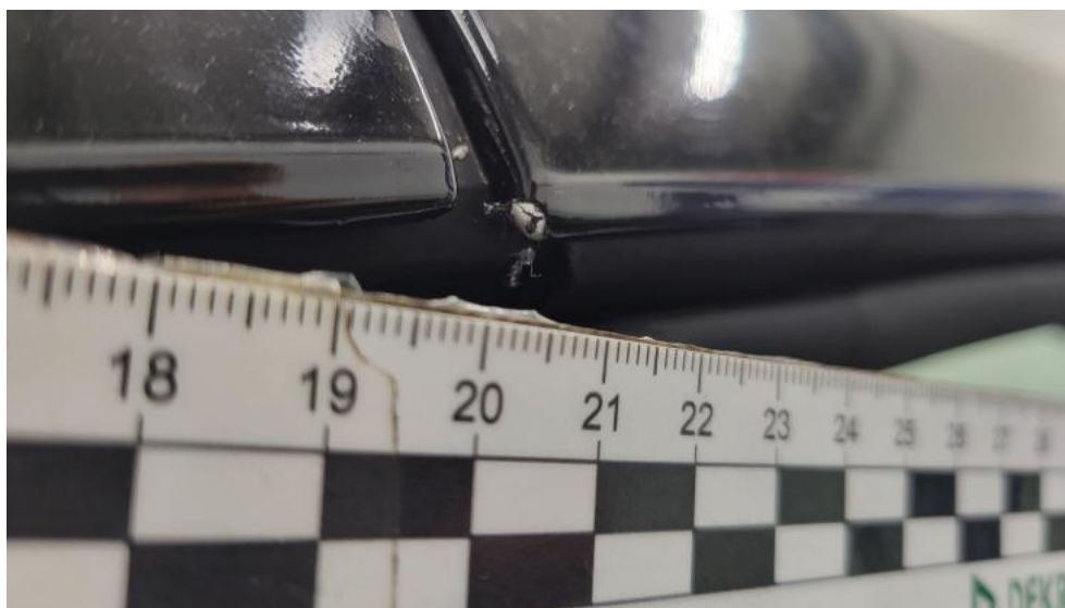
Fot. 77. Dach - Rysa/odprysk 1
