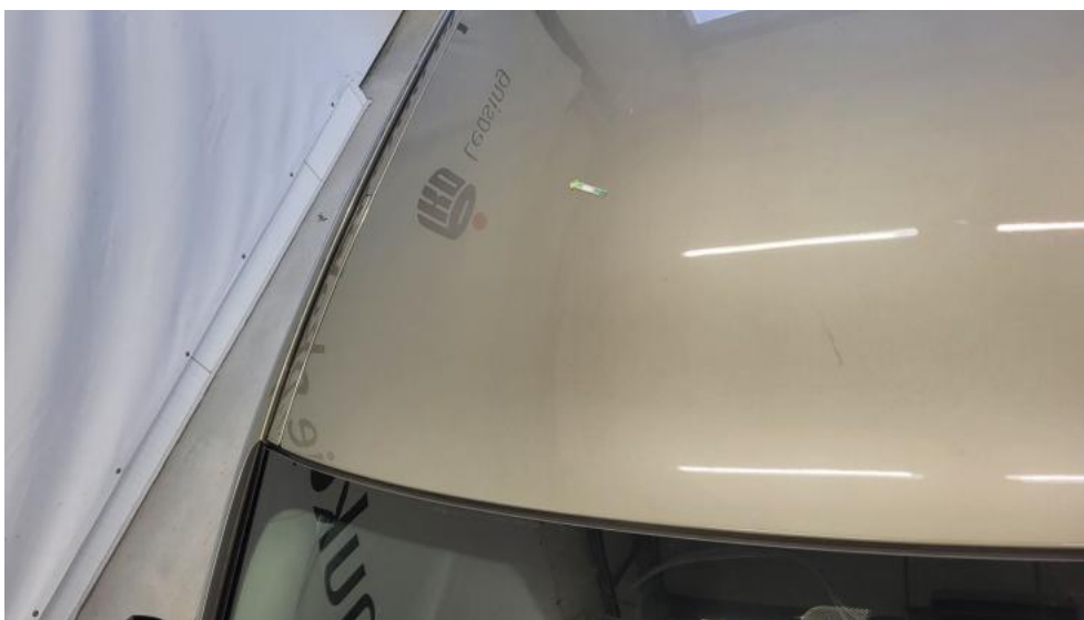
Fot. 61. Dach - zdjęcie poglądowe 1
