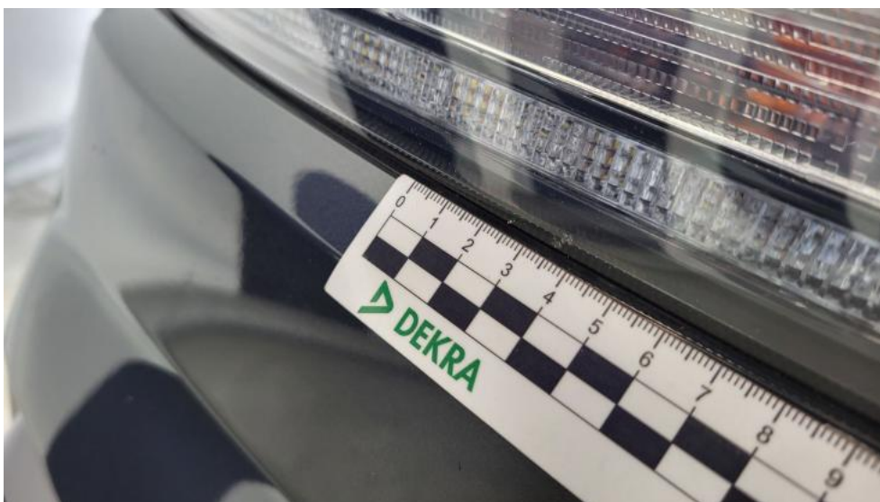
Fot. 40. Reflektor P - Rysa/odprysk 1
