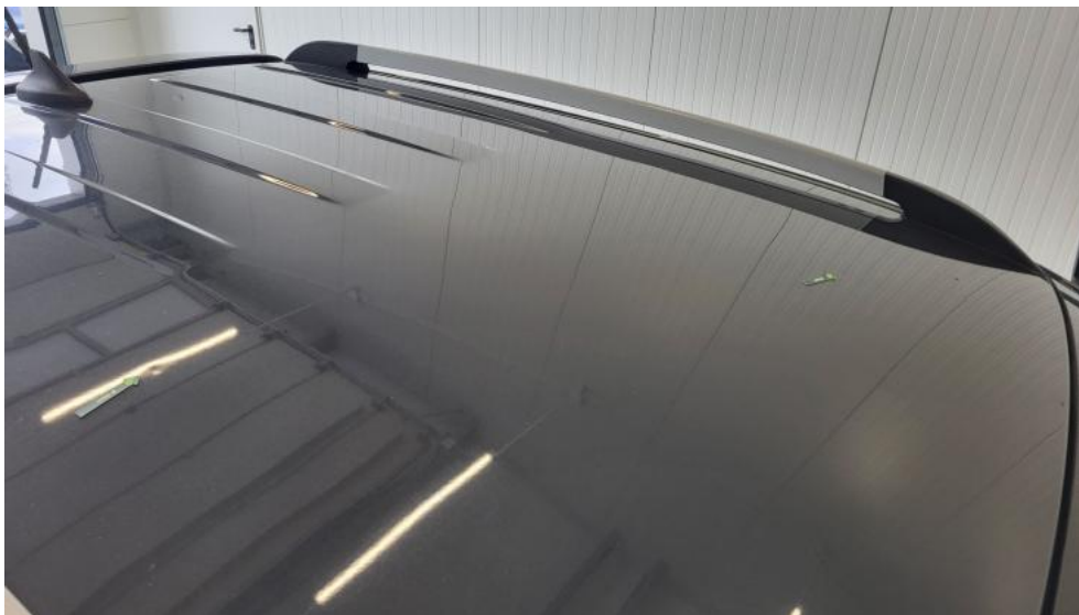
Fot. 55. Dach - Wgniecenie/odkształcenie 1
