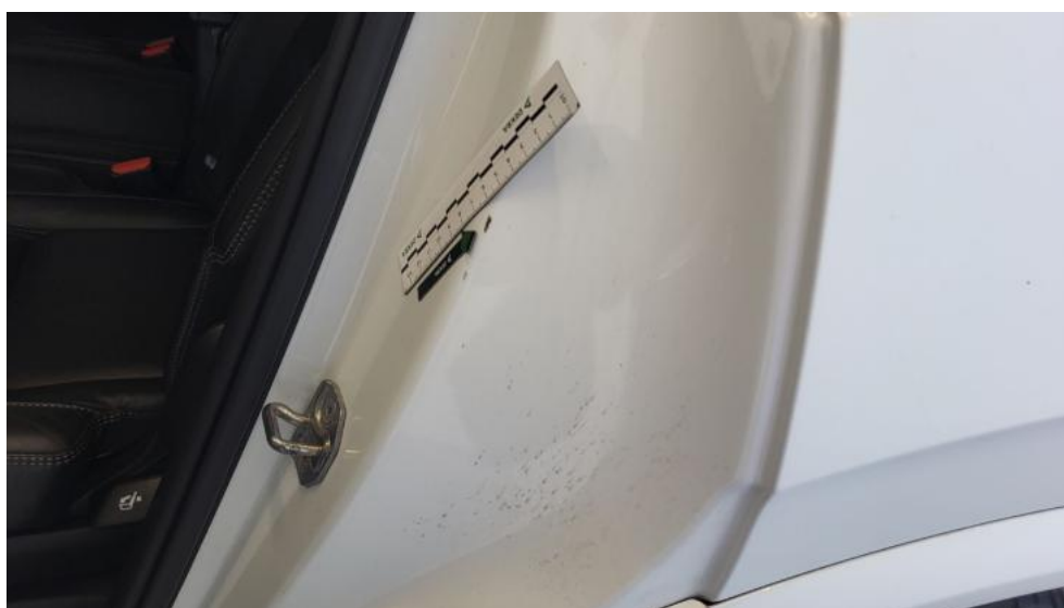
Fot. 54. Błotnik tylny L / Ściana boczna L - zdjęcie poglądowe 1
