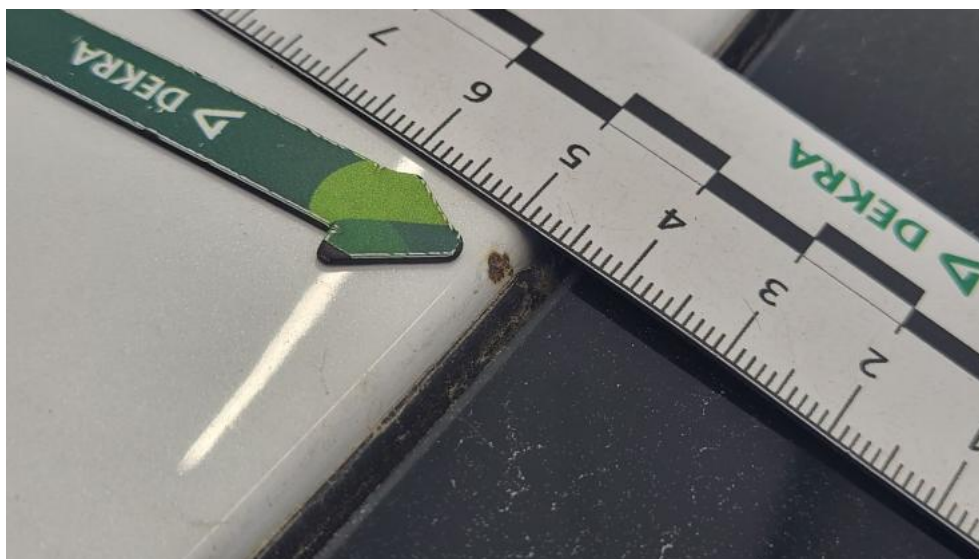
Fot. 53. Dach - Inne 1
