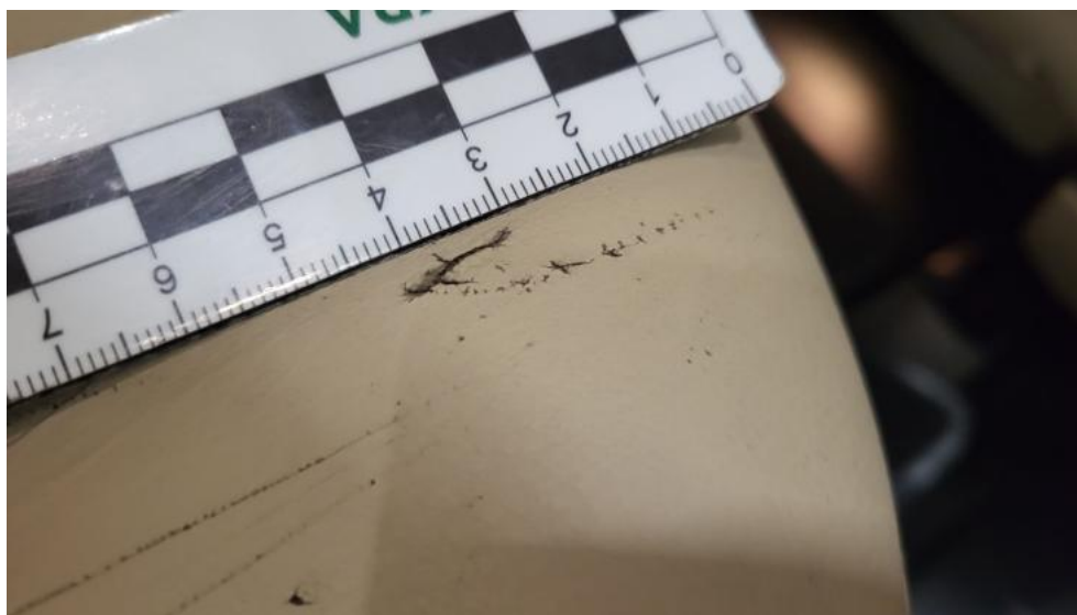
Fot. 87. Kanapa tyl. - Pęknięcie/rozerwanie 1
