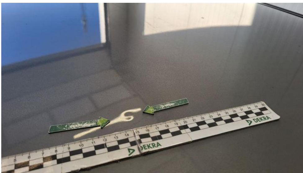
Fot. 58. Dach - Wgniecenie/odkształcenie 1
