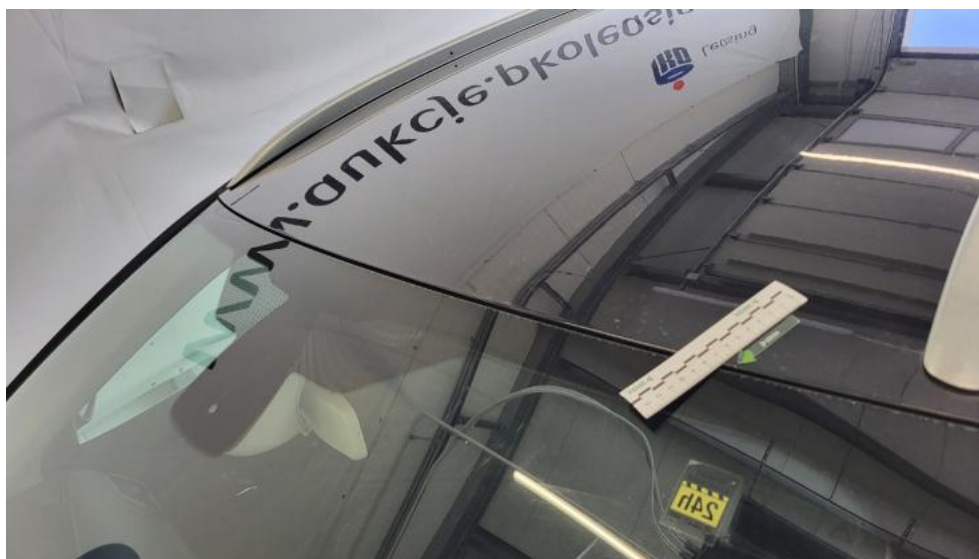
Photo 67. Dach - zdjęcie poglądowe 1
