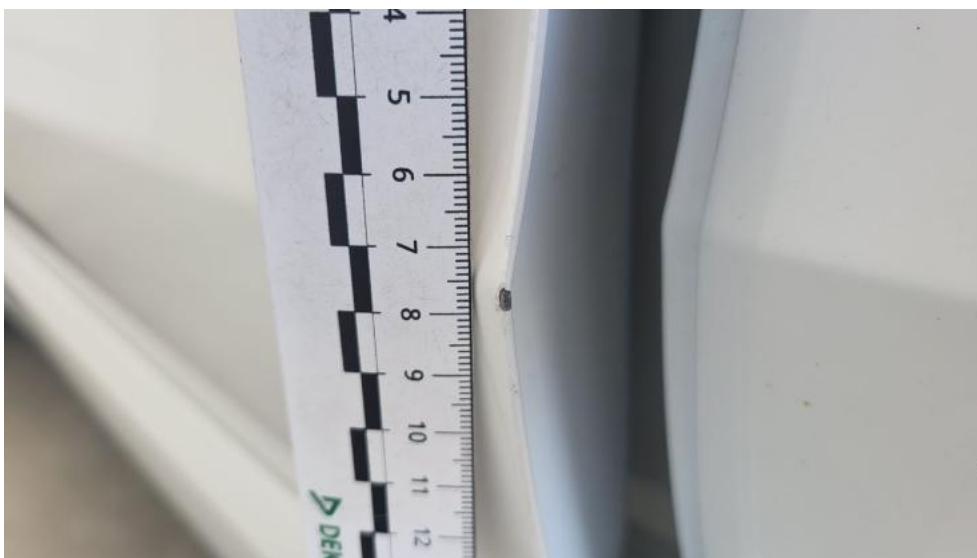
Photo 58. Drzwi przed L - Rysa/odprysk 1
