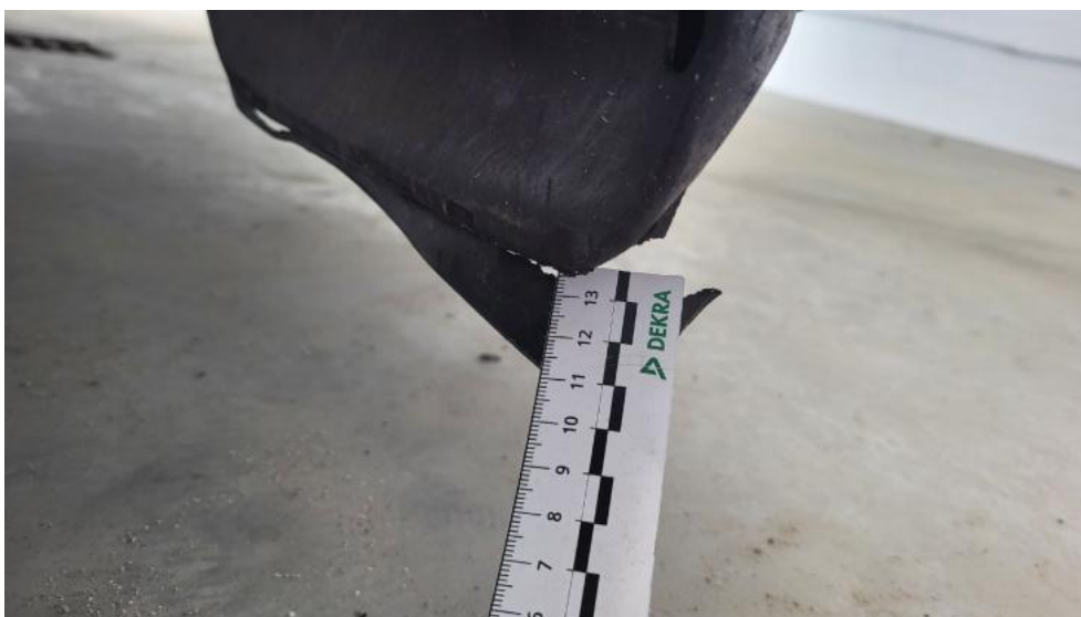
Fot. 46. Nadkole przednie P - Pęknięcie/rozerwanie 1
