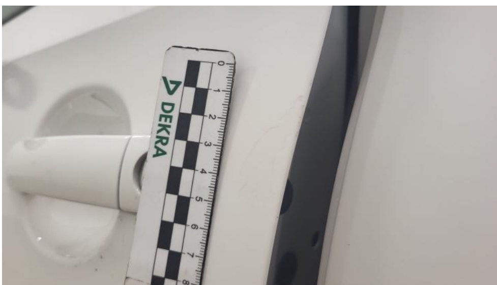
Fot. 54. Drzwi przed L - Inne 1
