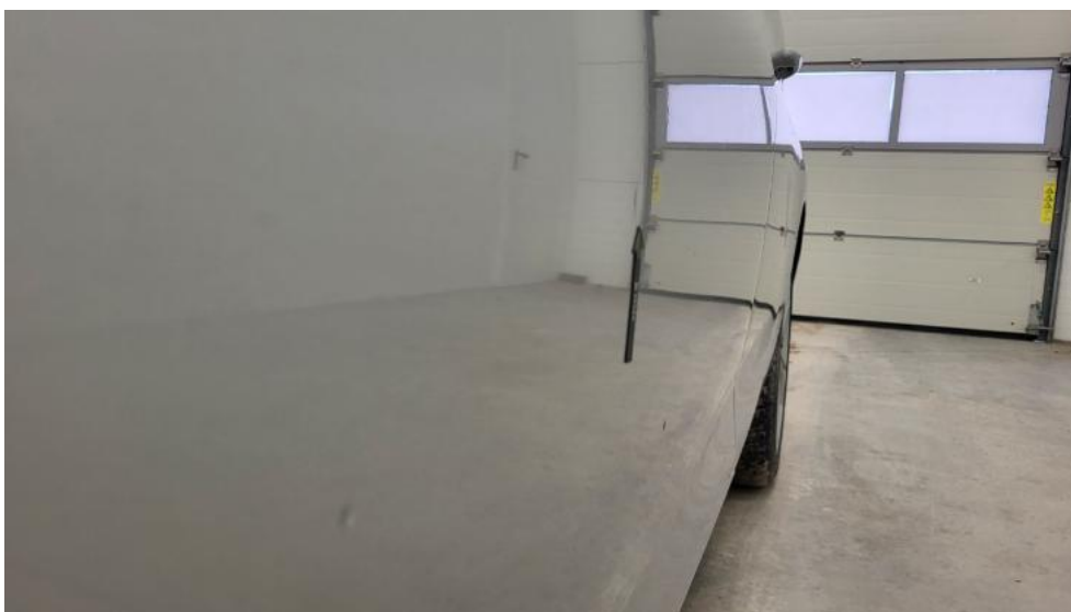
Fot. 66. Drzwi przed L - Wgniecenie/odkształcenie 1
