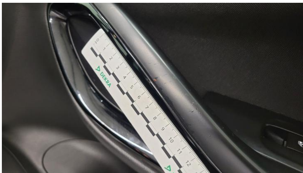
Fot. 79. Uchwyt drzwi prze P - Rysa/odprysk 1
