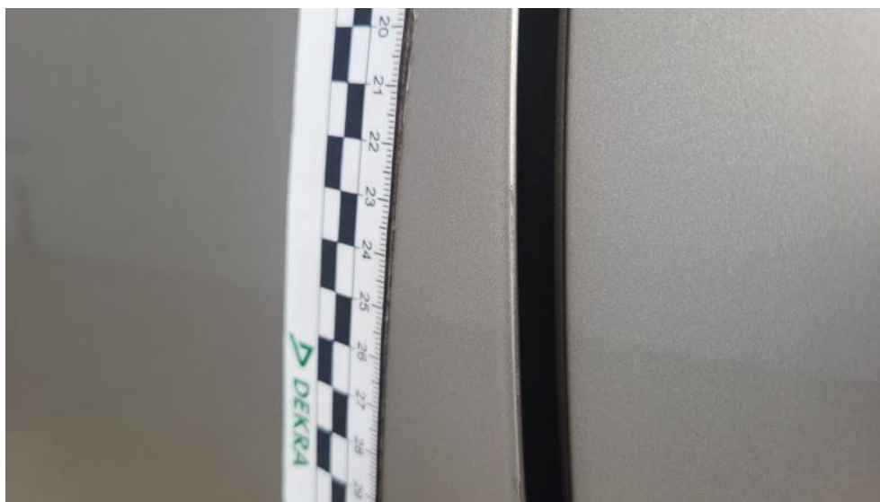
Fot. 49. Drzwi przed L - Rysa/odprysk 2
