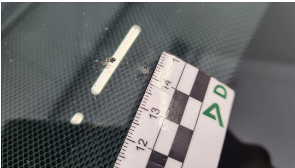
Fot. 41. Szyba czołowa - Pęknięcie/rozerwanie 1
