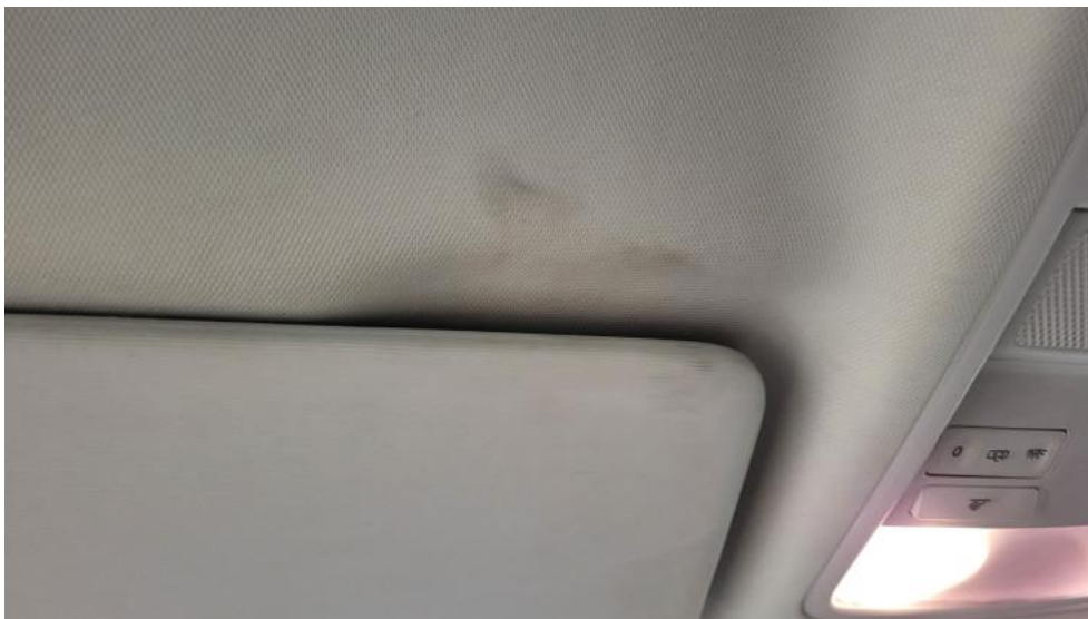
Fot. 89. Podsufitka - Inne 1
