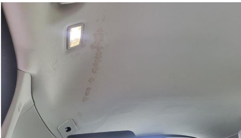
Fot. 76. Podsufitka - Inne 1
