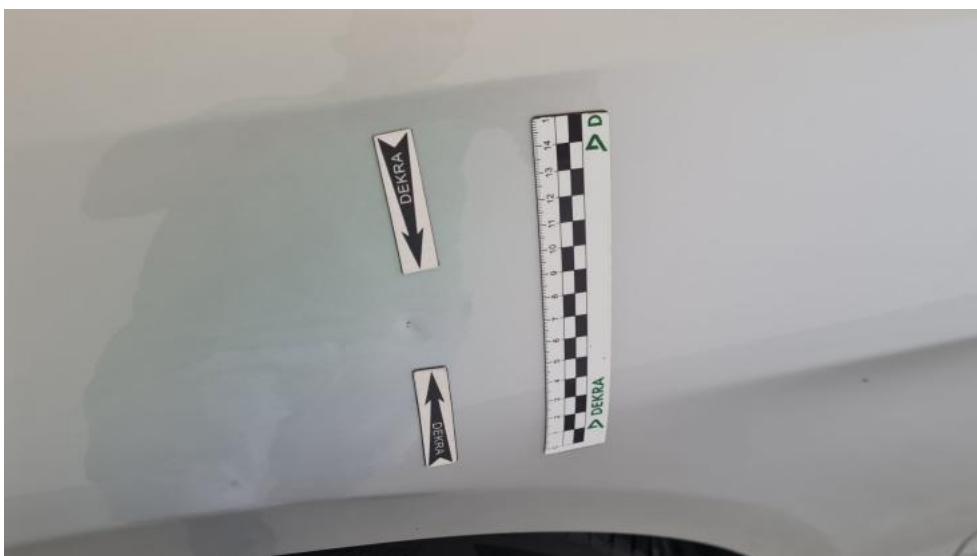
Fot. 58. Błotnik przedni L - zdjęcie pogładowe 1
