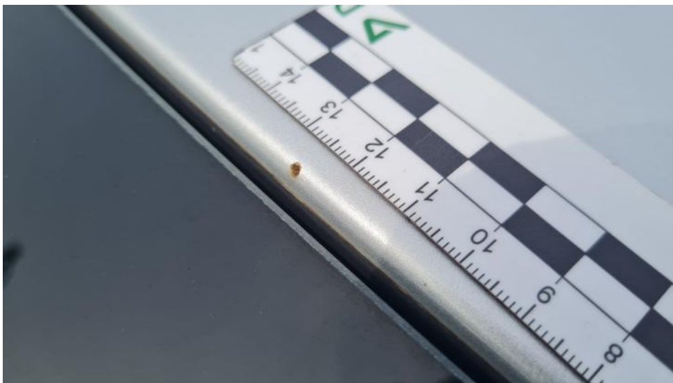
Fot. 53. Dach - Inne 1
