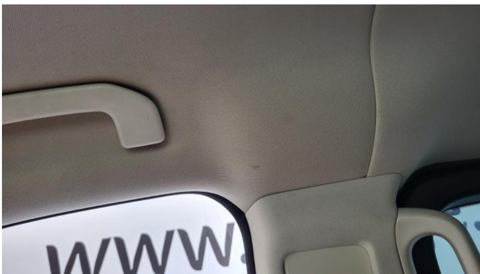
Fot. 76. Podsufitka - Inne 1
