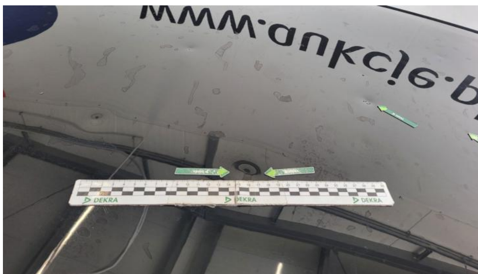
Fot. 99. Dach() - Wgniecenie/odkształcenie 3
