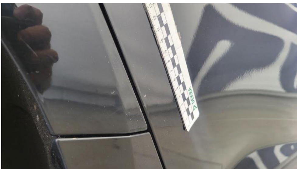
Photo 74. Drzwi tylne P - Rysa/odprysk 1
