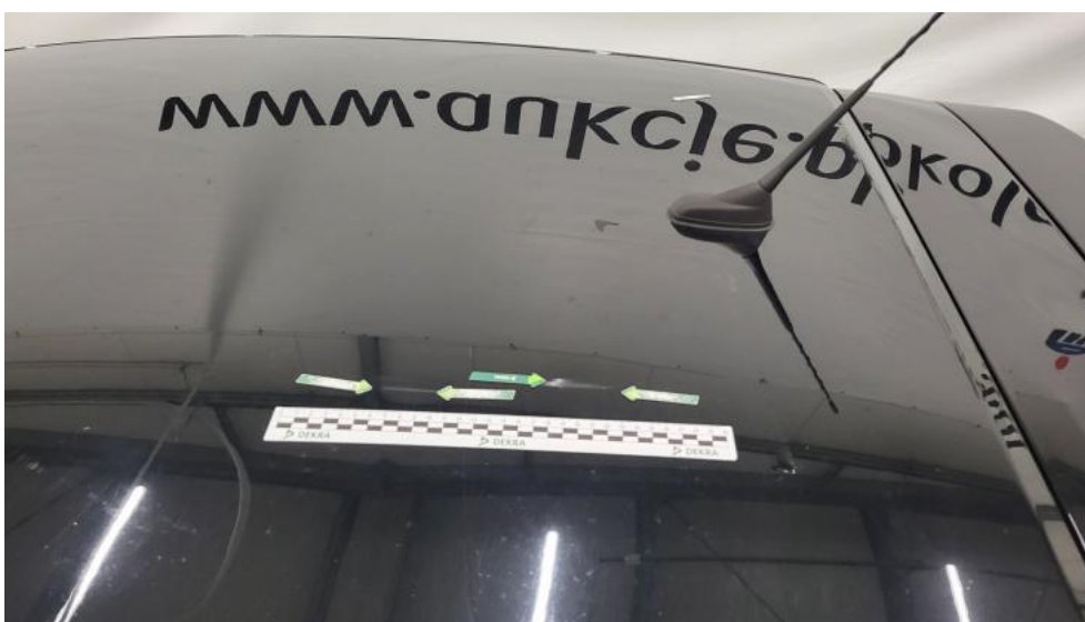
Fot. 68. Dach - zdjęcie poglądowe 1
