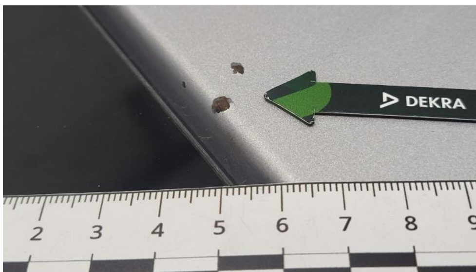
Fot. 70. Dach - Inne 1
